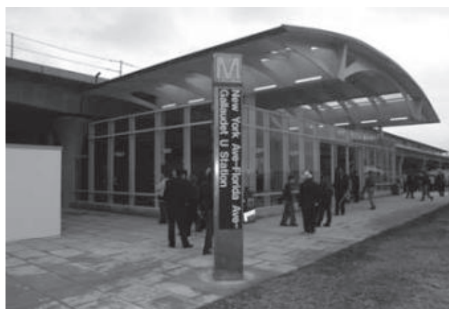
One entrance to the station / ein Eingang zur Station © WMATA
